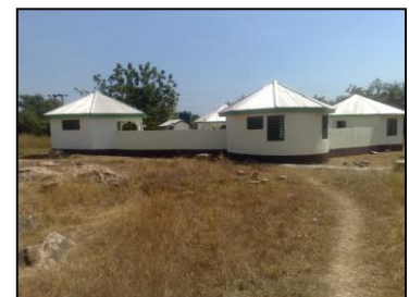
Die Gästehäuser sind fertig
